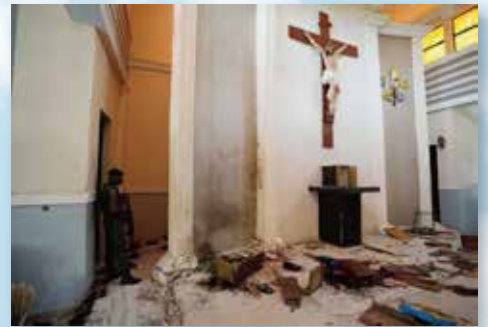
破壊された礼拝堂
