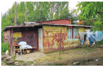
大地震後に建てられた仮住居
